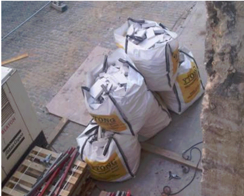
Figuur 32: Gebruik van de puinzak voor cellenbeton-snijafval op een grote Brusselse werf
