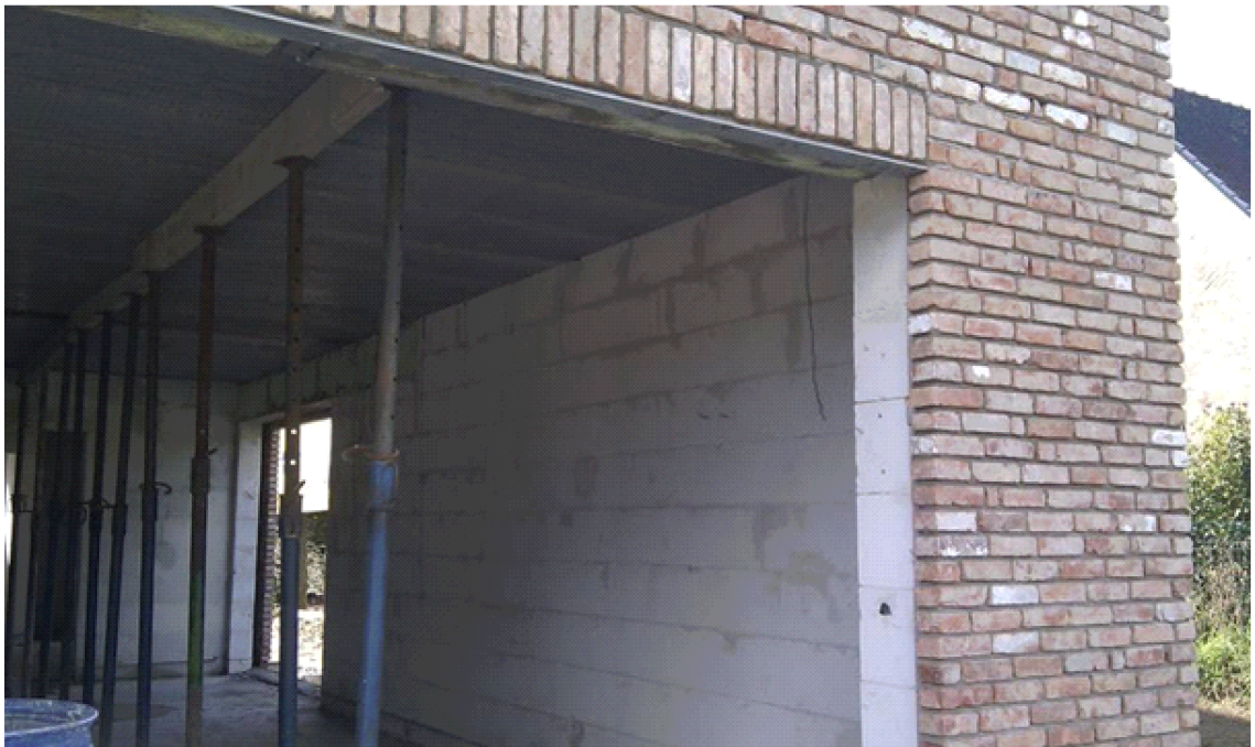
Figuur 22: Gebruik van cellenbeton voor binnenwanden
