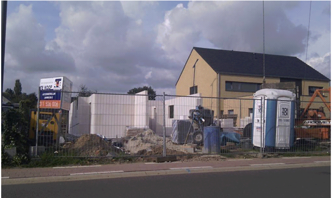
Figuur 21: Foto van werf waarbij dragende wanden in cellenbetonblokken worden uitgevoerd.
